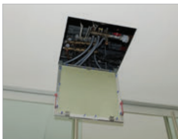
Inspecionabilidade do teto radiante em cartão gesso
